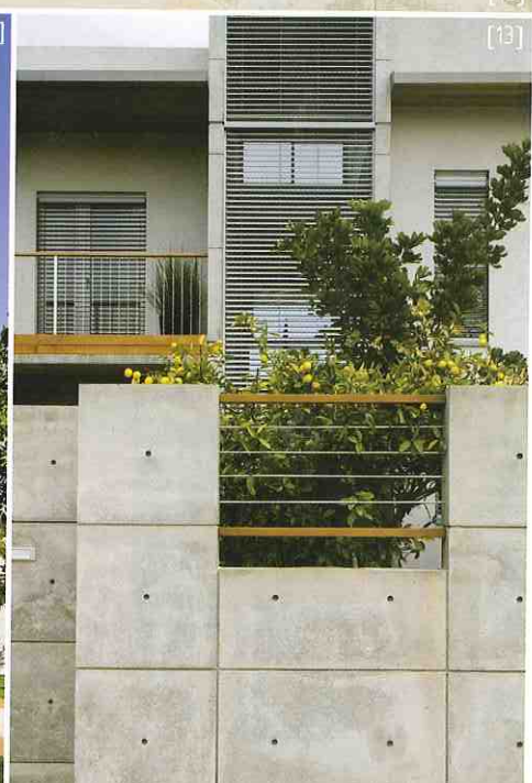
12-15. על רקע החזית המטויחת בולטים חדר המדרגות השקוף כאלמנט אנכי, מצחיית הכרכוב האופקית מעץ וחיפוי אבץ, מרפסת משותפת לחדרי הילדים מעל הכניסה.
