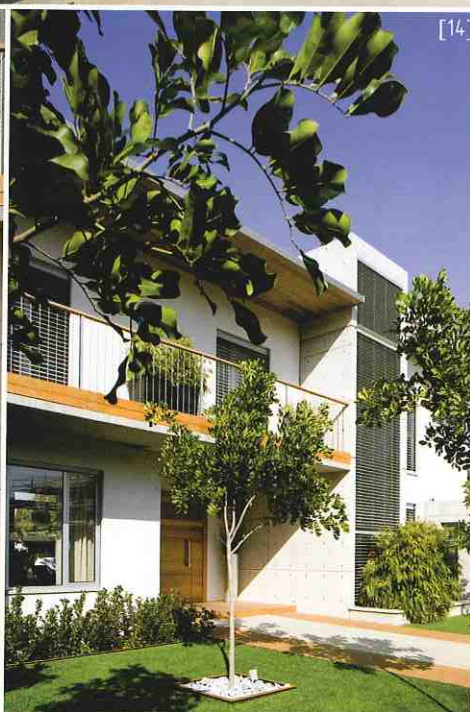
12-15. על רקע החזית המטויחת בולטים חדר המדרגות השקוף כאלמנט אנכי, מצחיית הכרכוב האופקית מעץ וחיפוי אבץ, מרפסת משותפת לחדרי הילדים מעל הכניסה.
